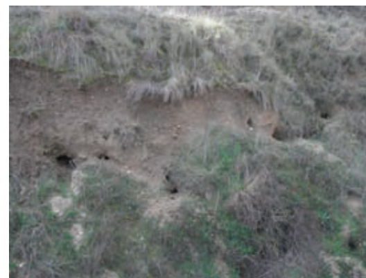
Conejeras en talud
