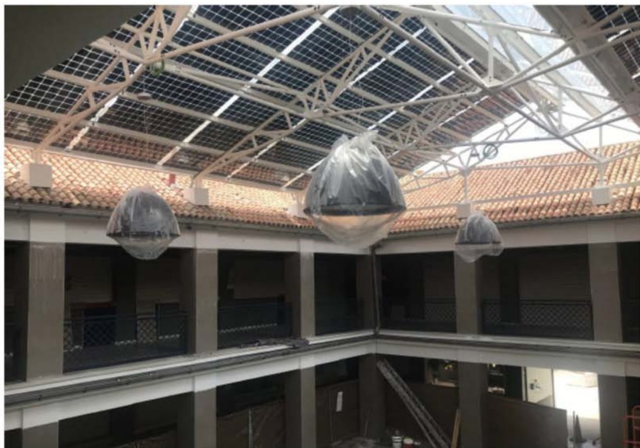
Después ejecución actuación A.6.1b)
