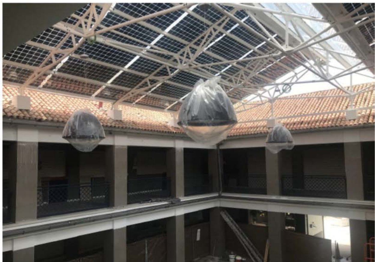
Después ejecución actuación A.6.1b)
