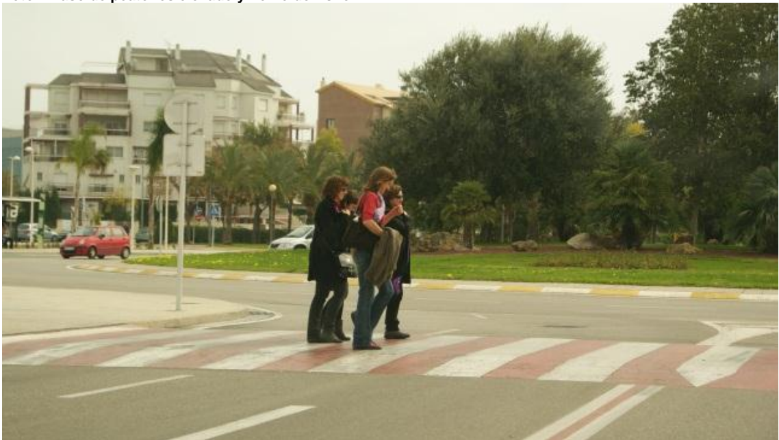
Foto 1 Paso de peatones elevado y Lomo de Asno
