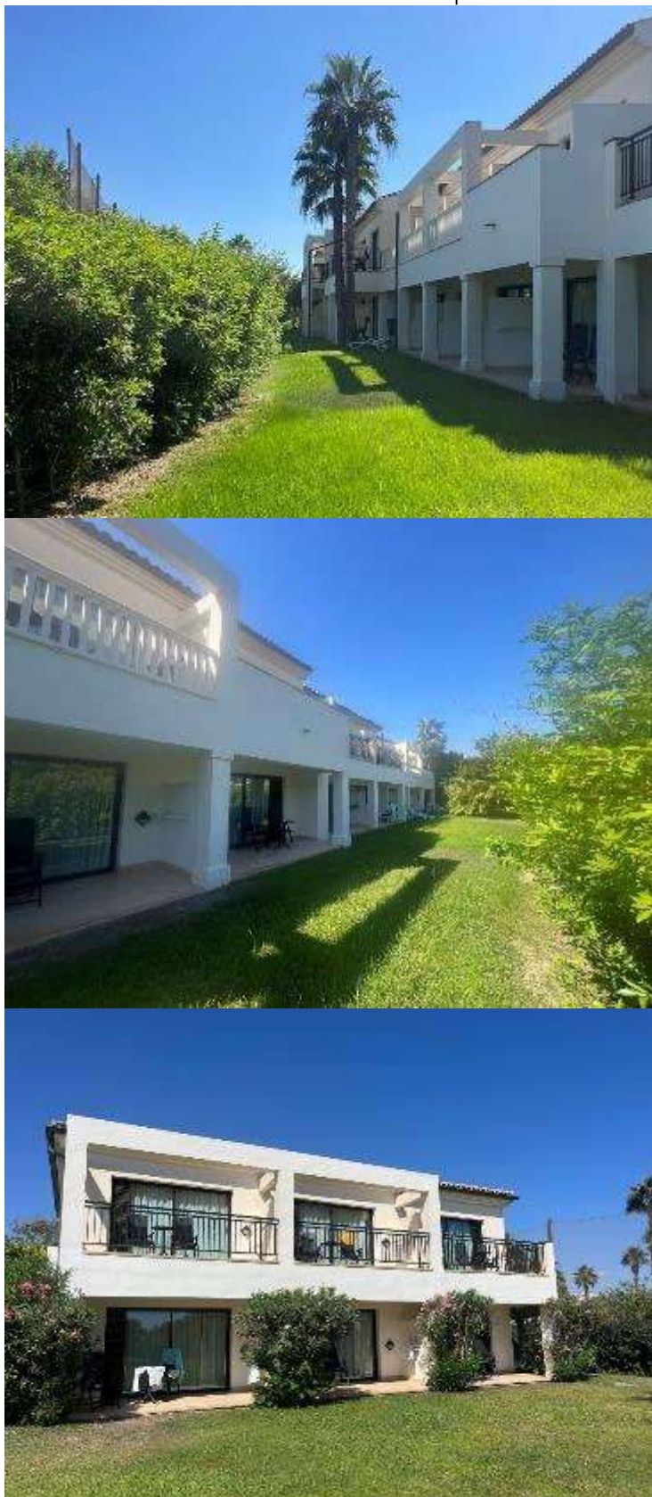
Modulo 11: exterior. Fachada a ampliar
